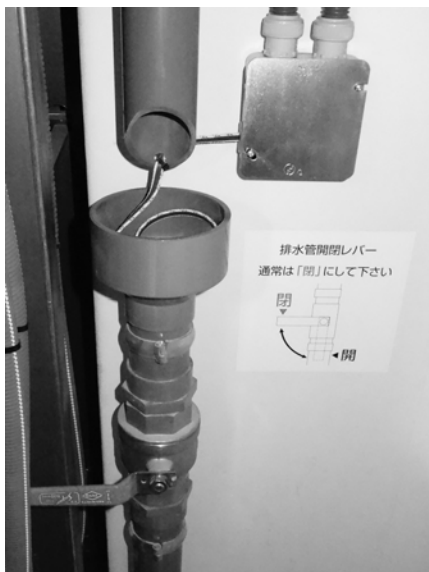
(写真4) チャンバー内水漏れ警報装置
