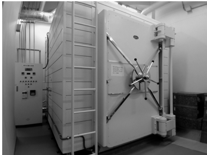
(写真6) 地下1階高減圧燻蒸装置
