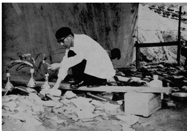
写真4 第14次調査 1961年 保存工事
