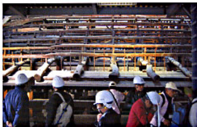
解体修理中の願泉寺の見学(屋根が目の前!)
